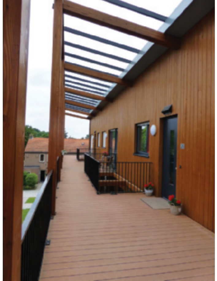
De galerijgevels zijn soberder van indeling. Let op de vides in de galerijvloer, die zorgen voor daglichttransport en privé-buitenruimten.
