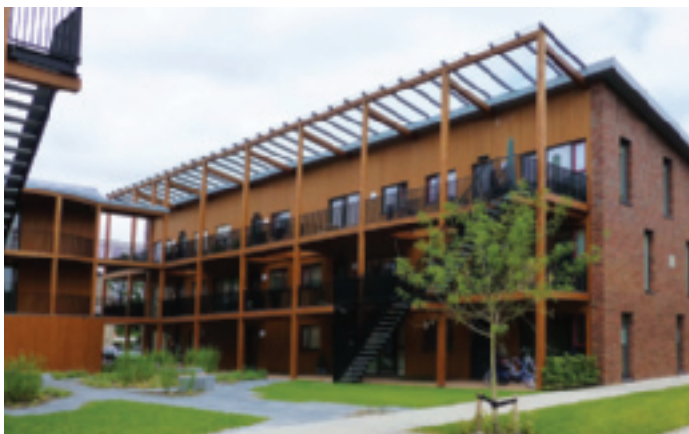
Het appartementencomplex bestaat uit twee spiegelbeeldige bouwblokken met daartussen een binnentuin.
