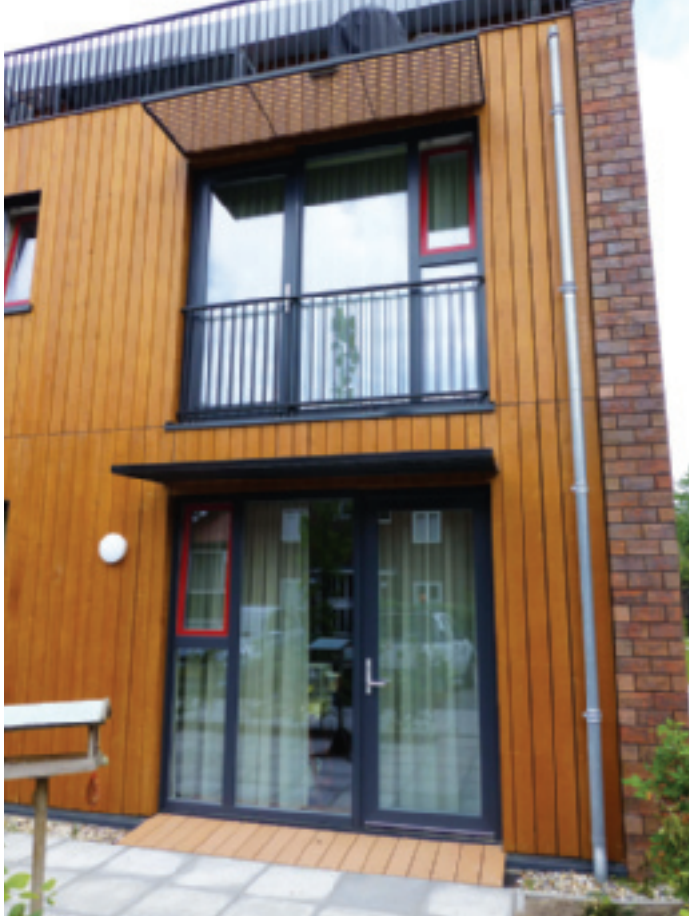
De kunststof kozijnen zijn ritmisch boven elkaar geplaatst met een Frans balkon voor de woning op de eerste verdieping.
