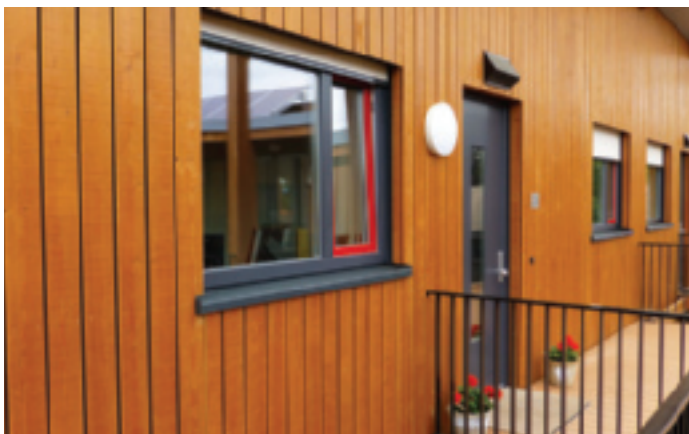
De kozijnen in de langsevel hebben een negge van 131 mm. Alle draairamen zijn roodgekleurd.
