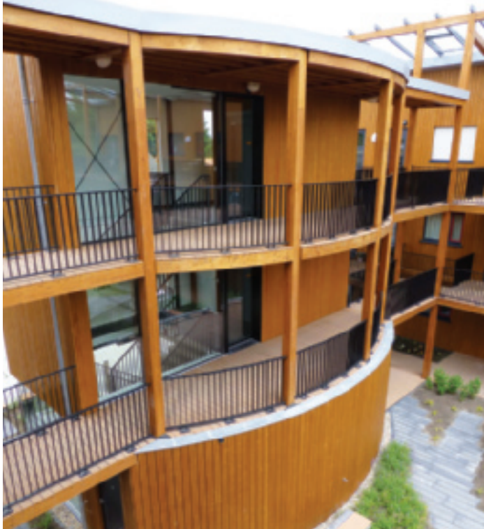
De zuidgevel van het entreegebouw loopt rond en is grotendeels open. Op de begane grond liggen twee bergingen achter de dichte gevel.
