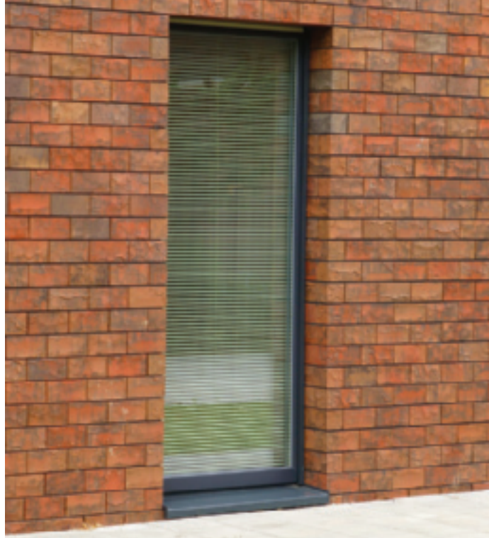
De vaste ramen in de kopgevels zijn met een negge van 216 mm zo diep mogelijk naar achteren gezet om de baksteengevel te accentueren.
